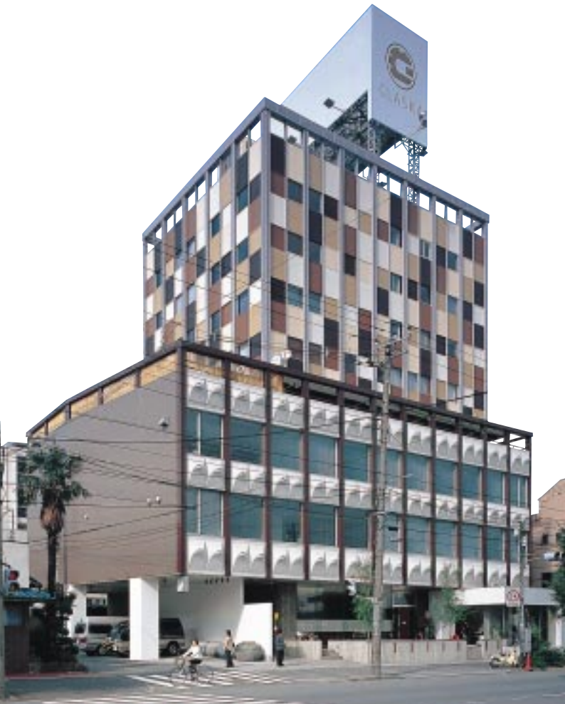
クラスカの外観。外装もインテンシオナリーズがデザインした。2～3階部分には、FRPの白いパネルを新たに取り付けた。「元からここにあったんじゃないかと思わせる」(鄭氏)ようなデザインが意識されている。4階以上は、窓の区割りを利用して5種類の色でグラフィカルに塗装している
