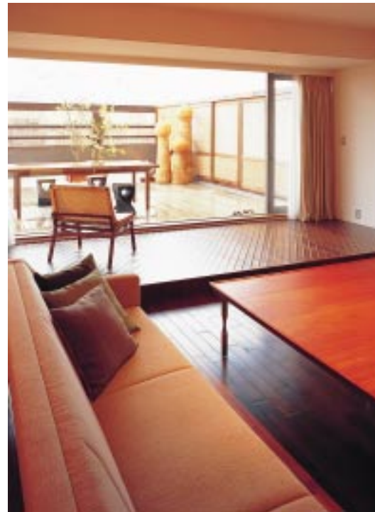
テラスの方向を見る。一段高い床には日本の伝統技術である「なぐり」を施した。チークのフローリングを手おで削り、波のような凹凸をつけた
